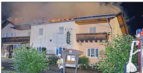
Flammen züngeln aus dem Dachstuhl des Gebäudes, dicker Qualm quillt hervor: Dieses Bild bot sich am späten Sonntagabend den Einsatzkräften. – Foto: Danny Jodts/zema-foto.de
